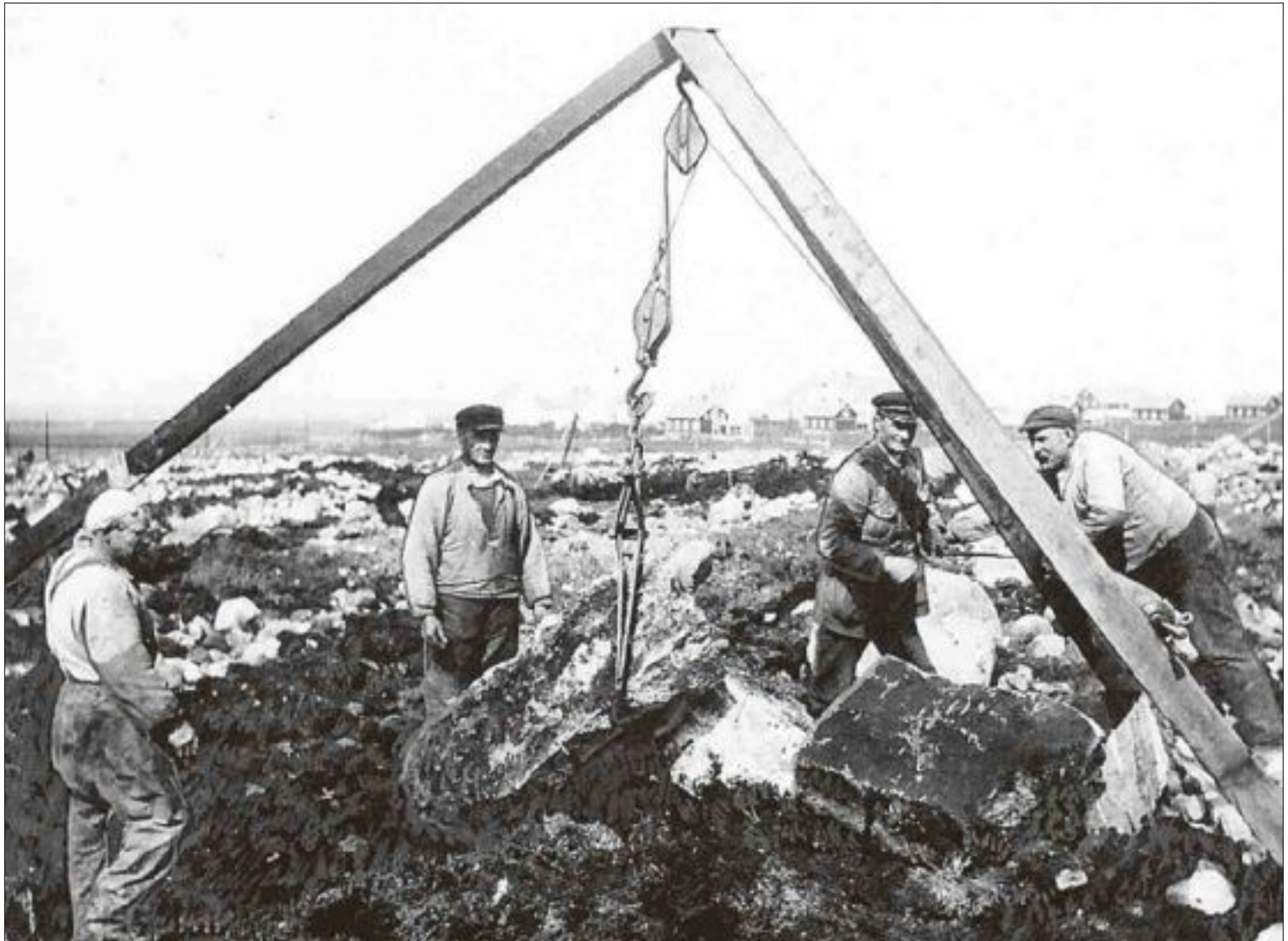
ARBEID: Nybrottsarbeidet foregikk med bruk av enkle mekaniske hjelpemidler som denne steinbukken. Her er en arbeidsformann i tett samarbeid med tre tvangsarbeidere. Foto fra Åna, sørvest for anstalten, som ses i bakgrunnen. Foto: ukjent (hentet fra boken).
